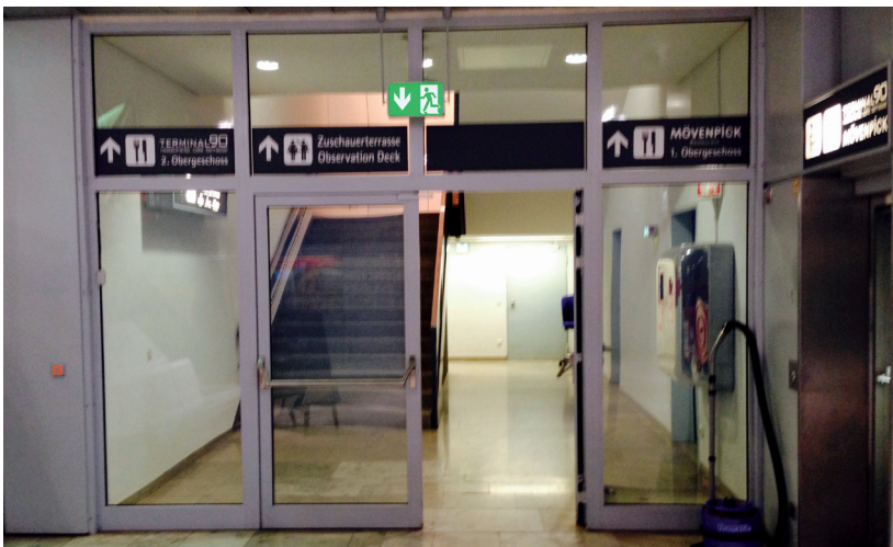
Abb. 2: Übliche Kennzeichnung der Fluchtwege und Notausgänge
